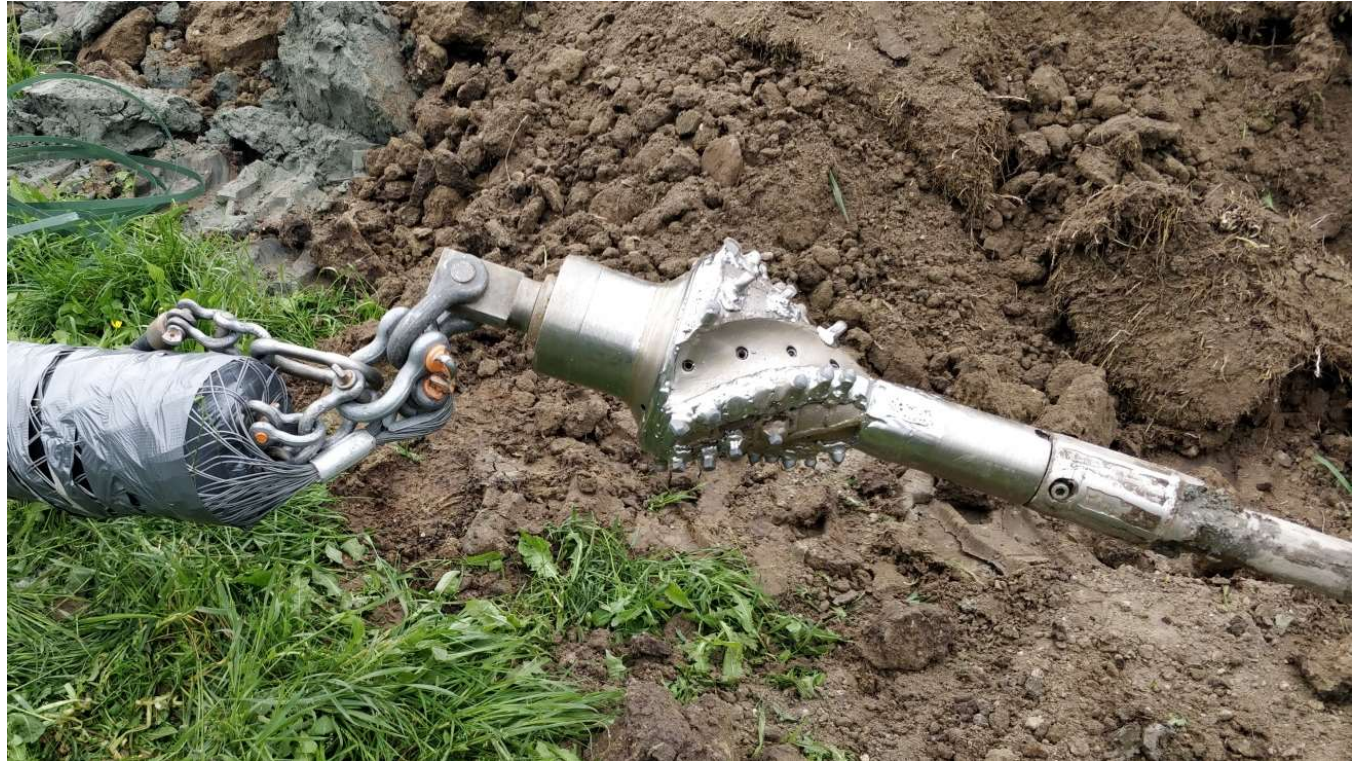
Grabenlose Verlegung im günstigen Spülbohrverfahren
