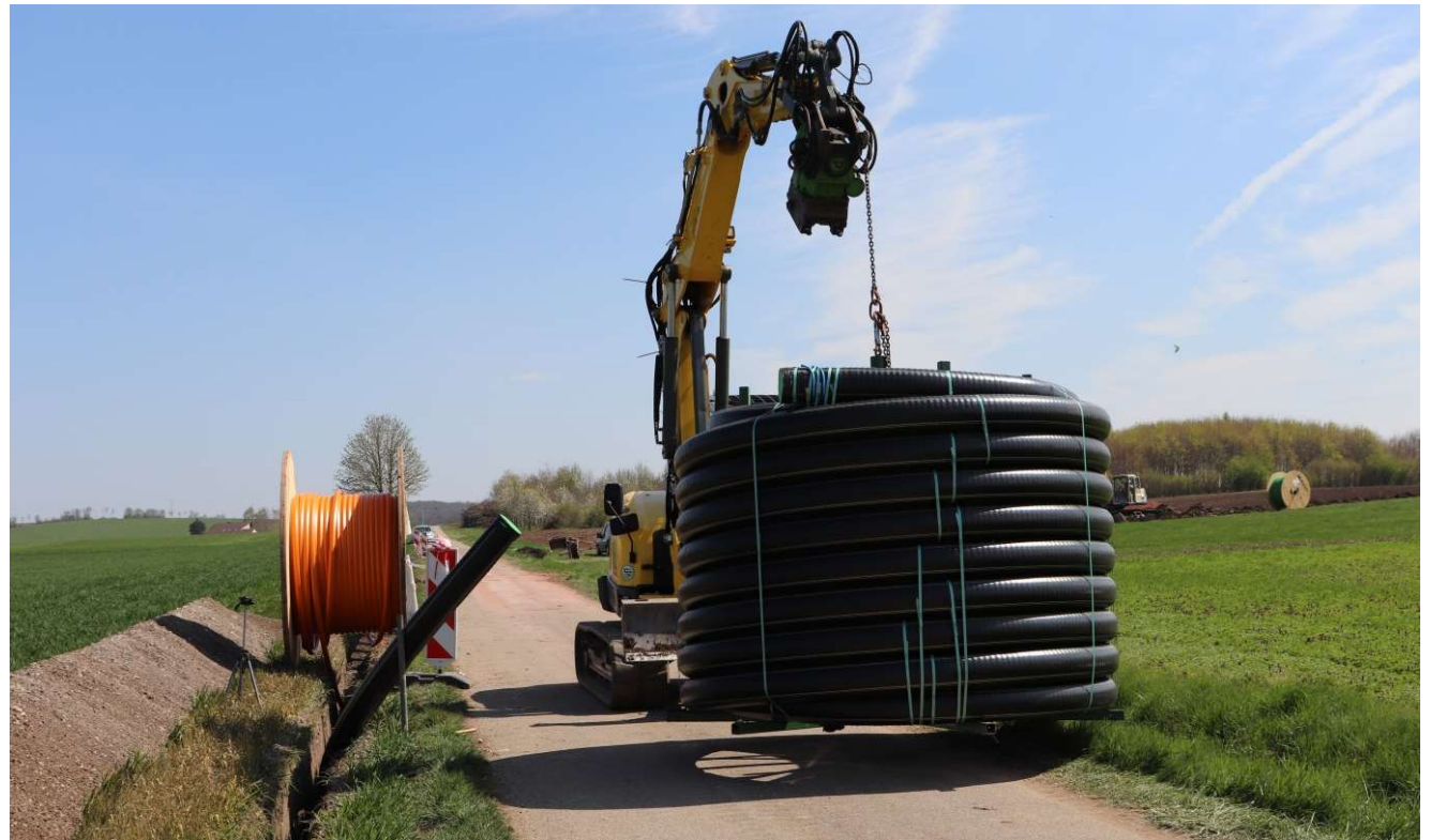
Grabenfräse + Verlegung der Wärmerohre
