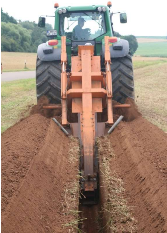
Grabenfräse + Verlegung der Wärmerohre
