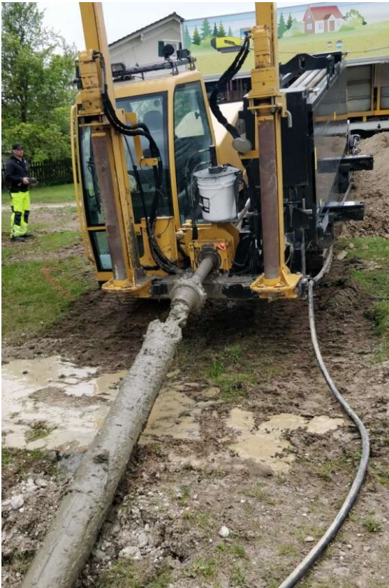
Grabenlose Verlegung im günstigen Spülbohrverfahren
